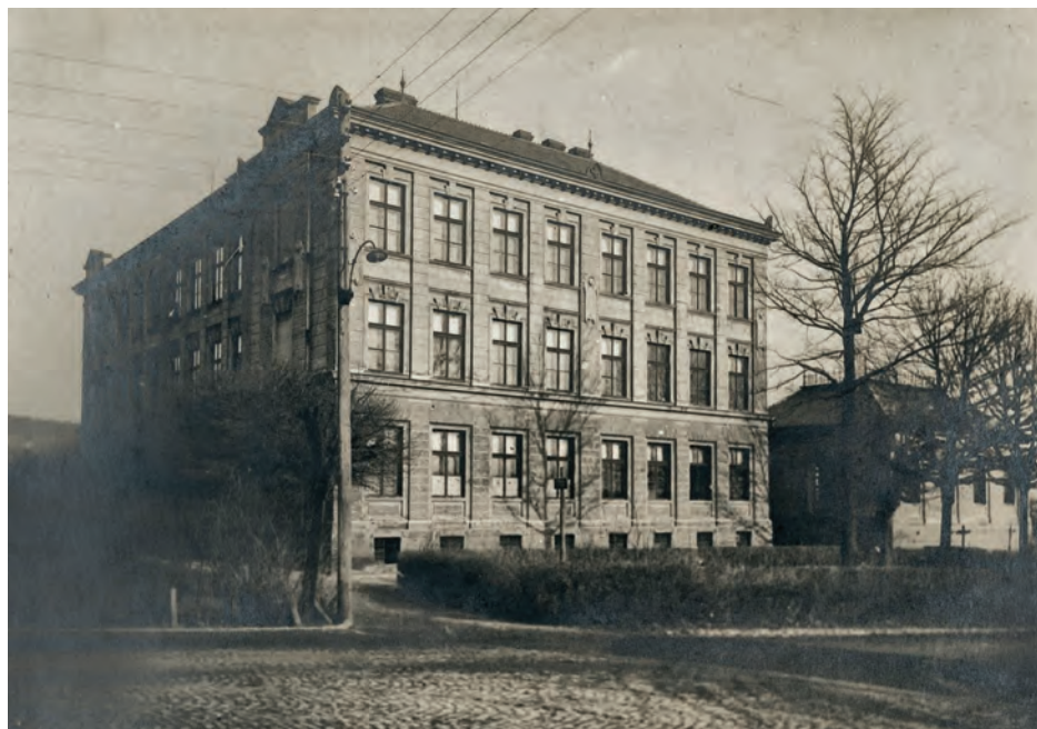
Budova Německé obecné školy ve Varnsdorfu, 30. léta 20. století. NPMK.
